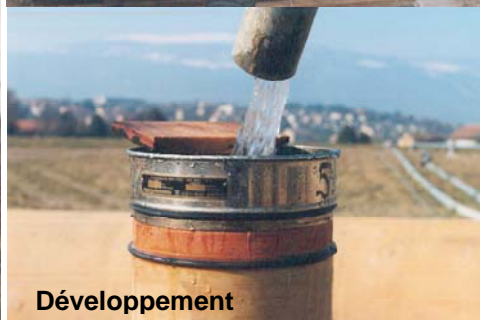
Tête du puits
