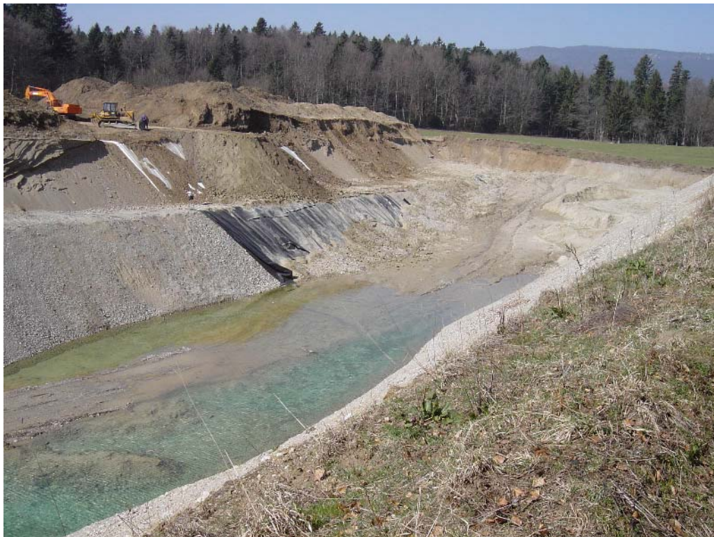
Vue de la tranchée principale
